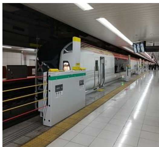
空港第2ビル駅 JR線ホームドア（昇降式ホーム柵）
