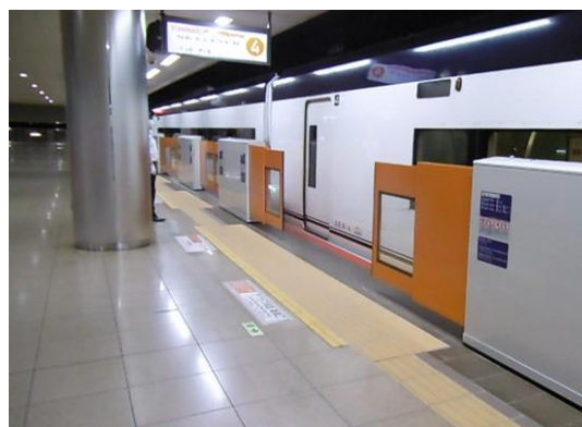
成田空港駅 京成線ホームドア
