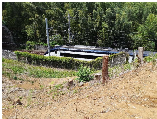
沿線近接樹木伐採工事
