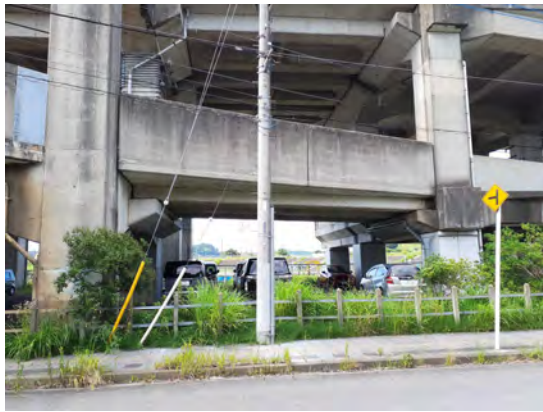
高架橋落下物対策 施工前
