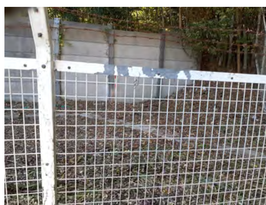
沿線近接樹木伐採・除草後
