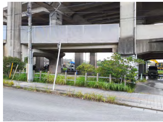
高架橋落下物対策 施工後
